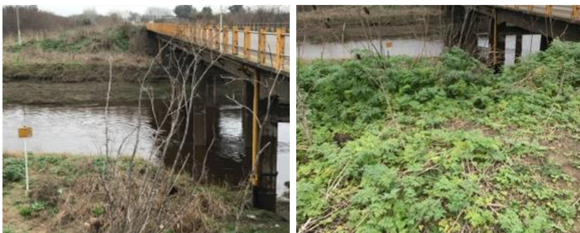
Figura 4-49. Cartelera indicando la cañería de gas
