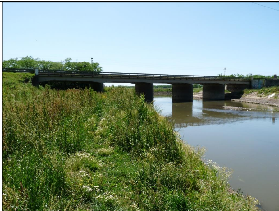
Figura 4-4. Puente de la Ruta Nacional N°8
