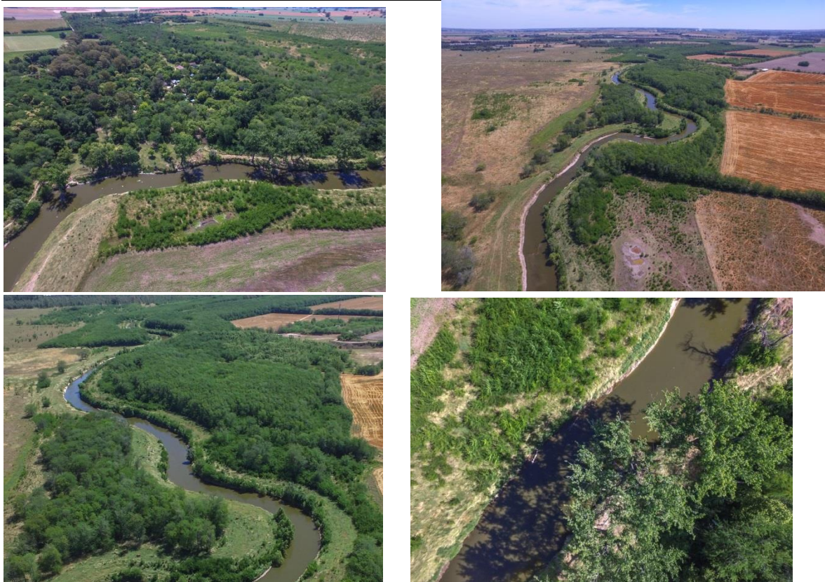
Figura 5-9. Fotos del sector de la obra correspondiente al sector aguas arriba del Camping. (Cambio de margen de canalización)
