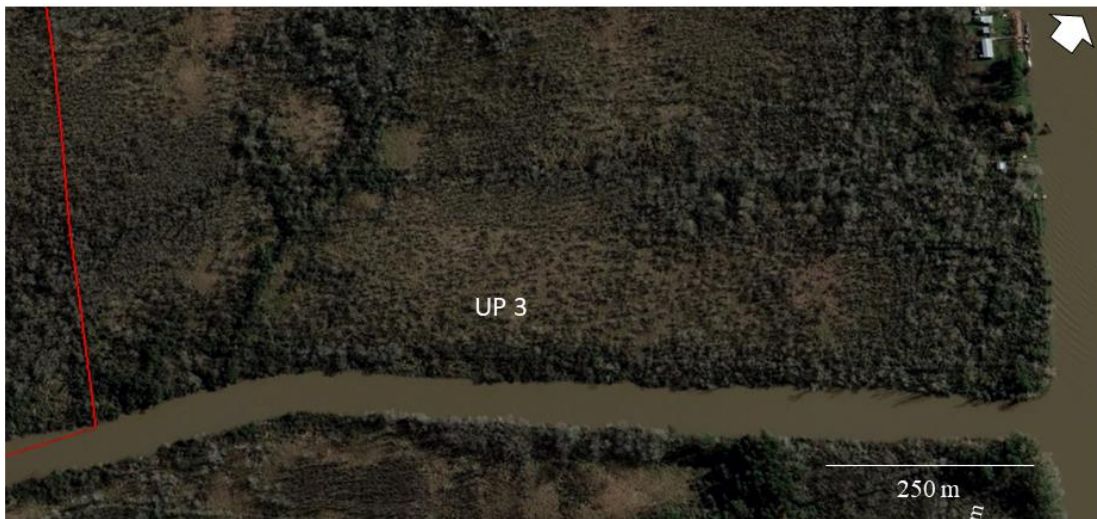
Figura 89: Sección 4 de la obra de ampliación del canal.
