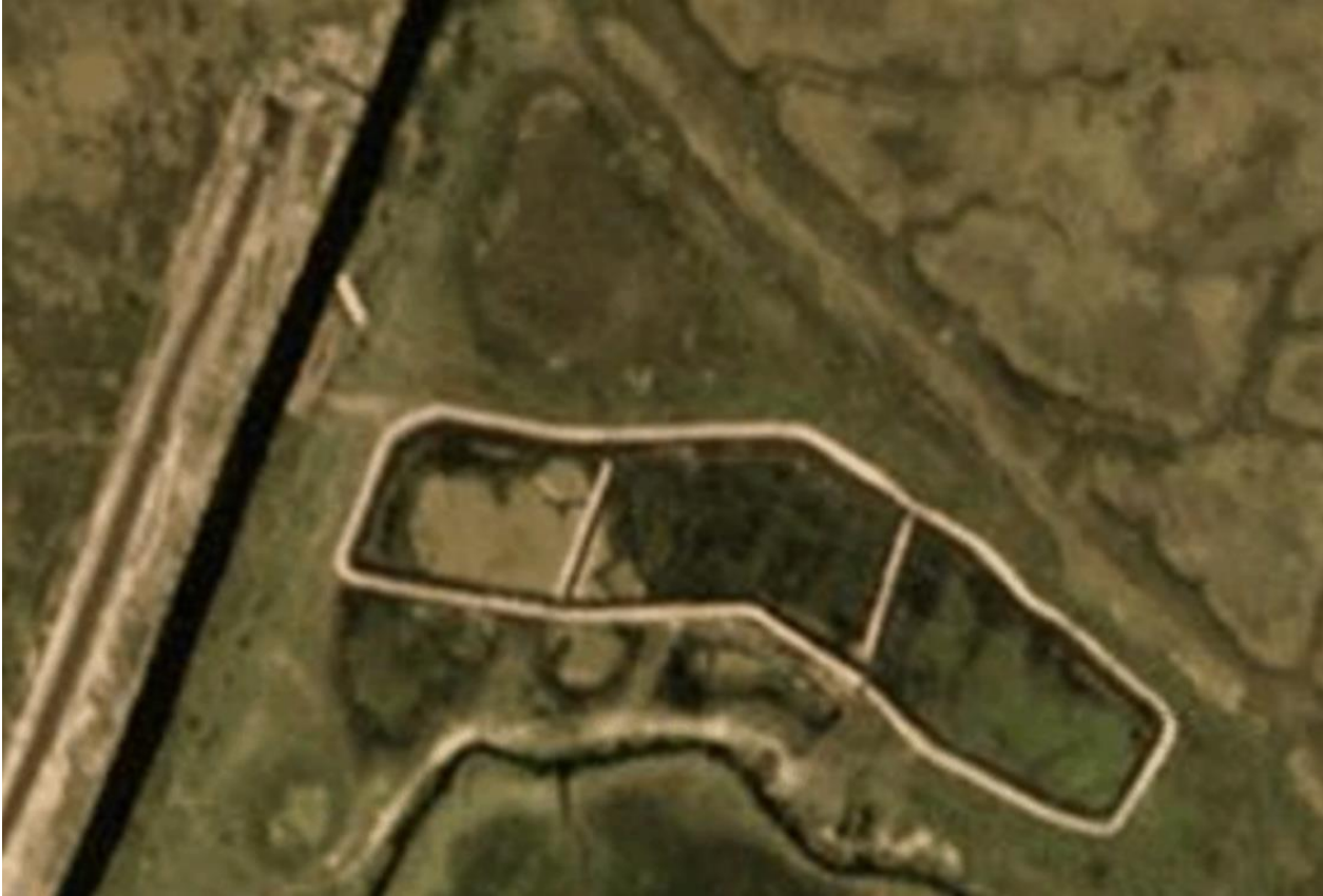
Figura 6: Imagen satelital del Recinto A construido sobre área del PN en cercanía del río Luján.
