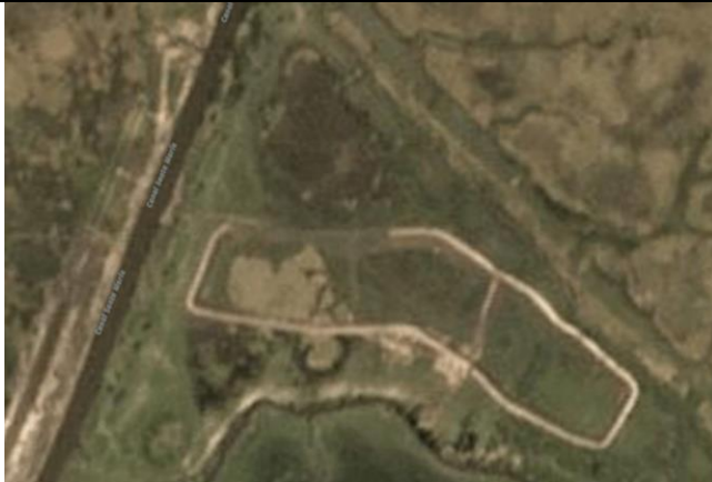
04/12/18 - Avance de la construcción
