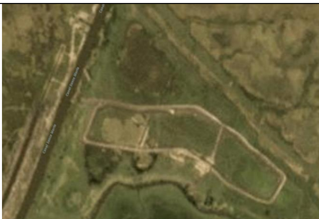
10/12/18 - Avance de la construcción
