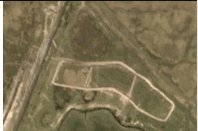
08/12/18 - Avance de la construcción
