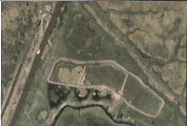
15/12/18 - Avance de la construcción
