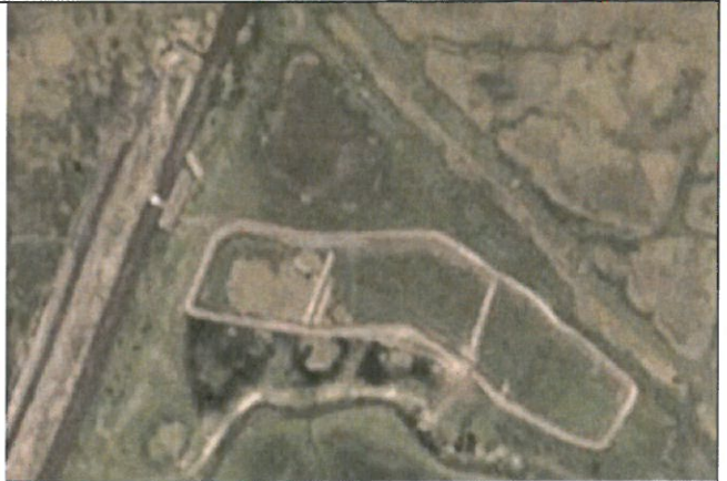
16/12/18 - Avance de la construcción
