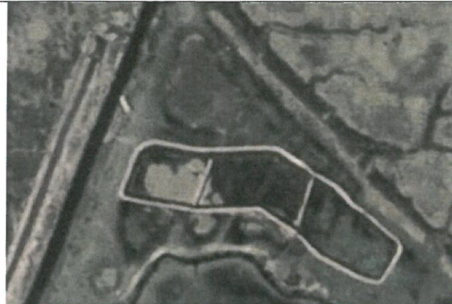
22/12/18 – Avance de la construcción
