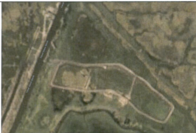
10/12/18 - Avance de la construcción
