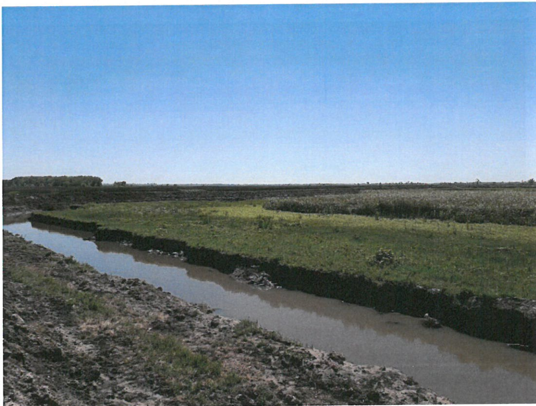
Figura 107: Vista interna del recinto A. Se observa la zona de extracción de material donde se generó huella en función al avance de la maquina dentro del recinto.
