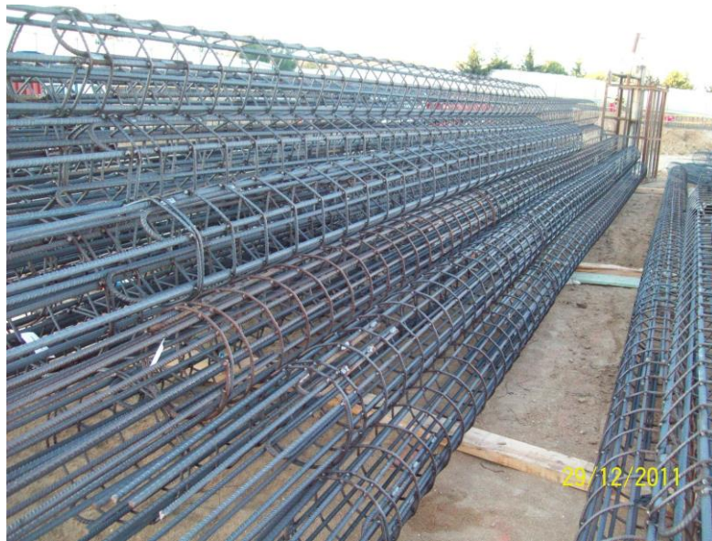
Figura 11: Acopio de armadura en banco de trabajo
