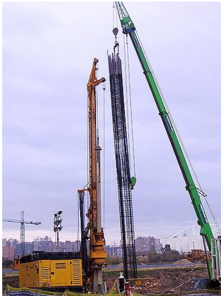
Figura 12: Colocación de armaduras a través de grúas
