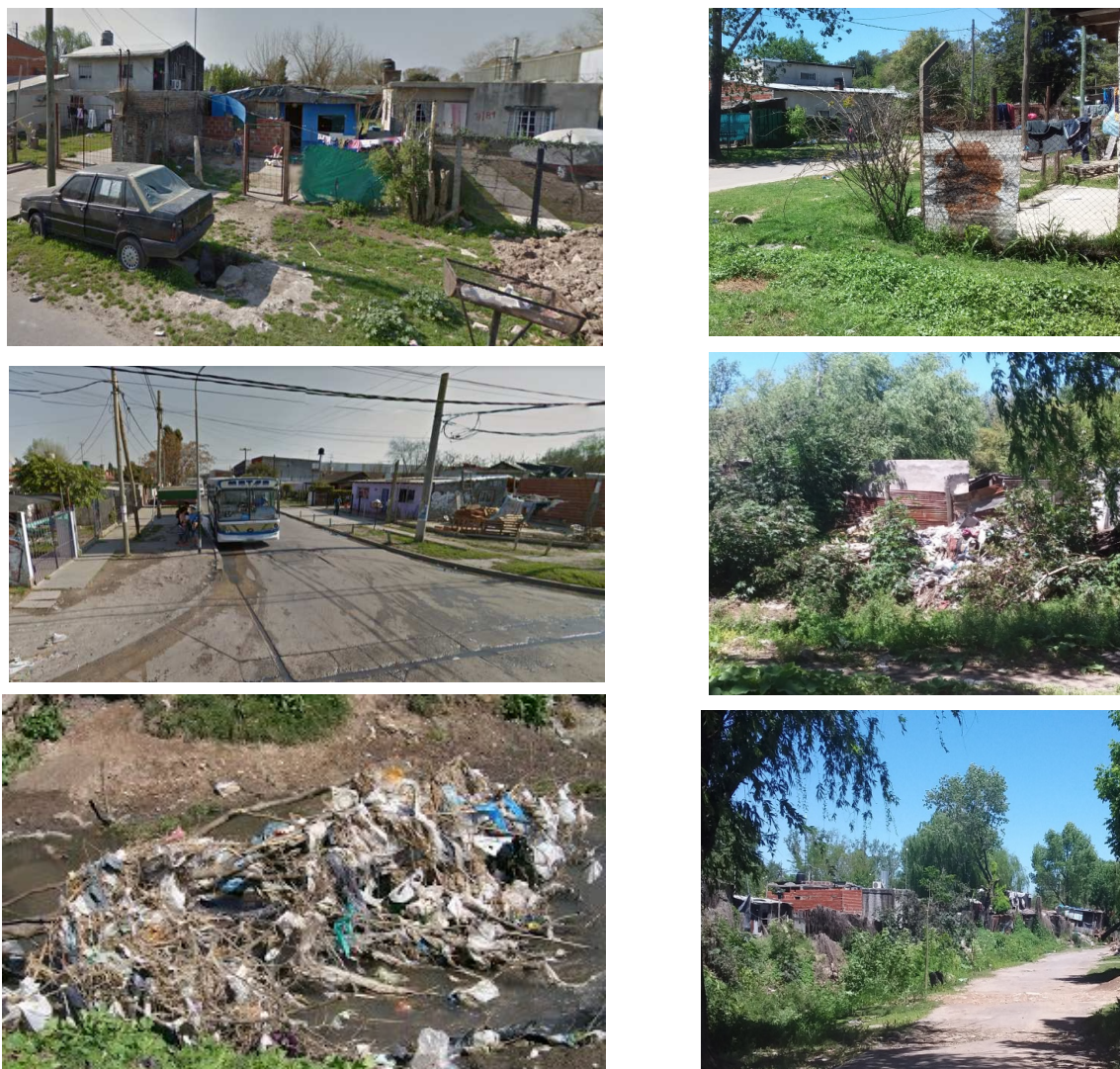
Figura 43b: Viviendas, calles y basura en las veredas -Barrio Las Tunas – Elaboración COMIREC, 2019.
