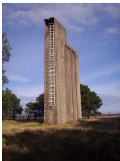
Figura 5: Acueducto Principal – Hormigón Pretensado
