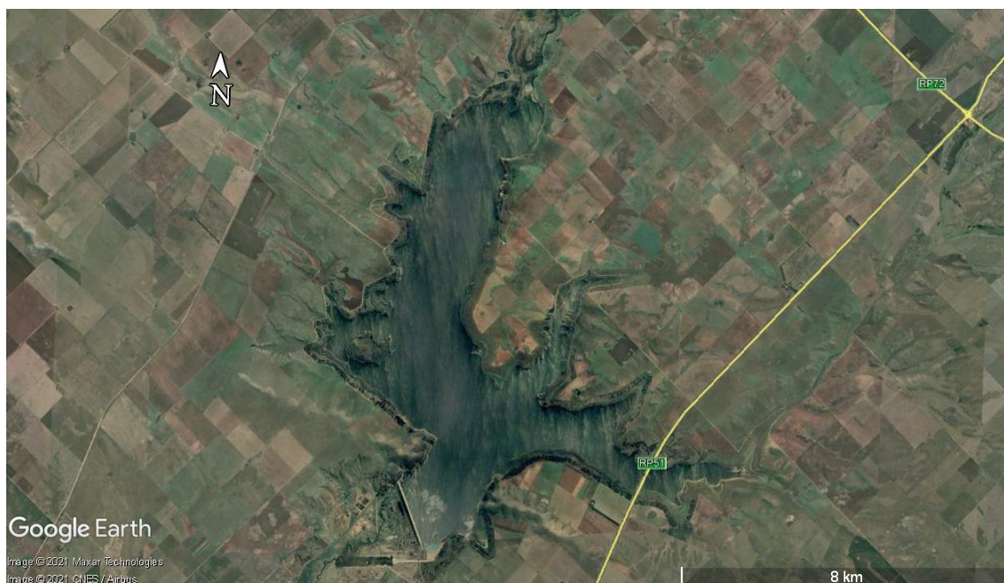
Figura 2: Imagen Satelital – Dique Paso de las Piedras
