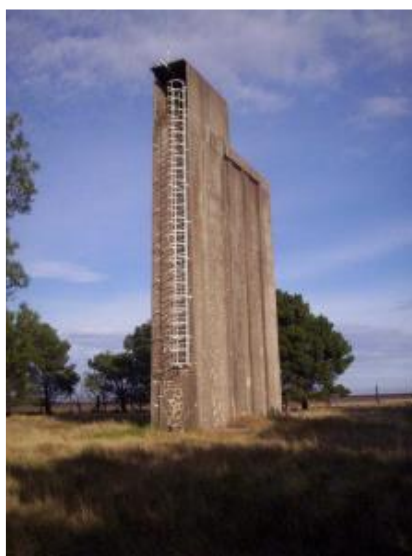
Figura 5: Acueducto Principal – Hormigón Pretensado
