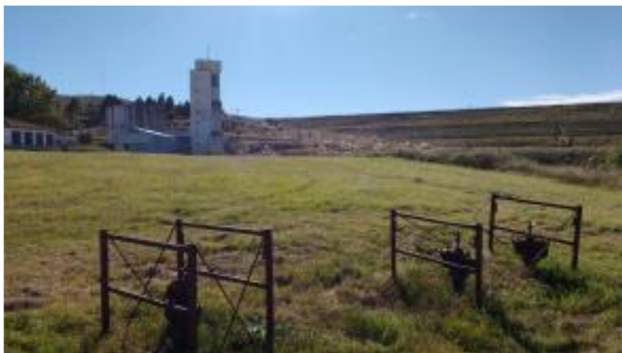
Figura 6: Cuadro de válvulas salida casa de bombas Dique
