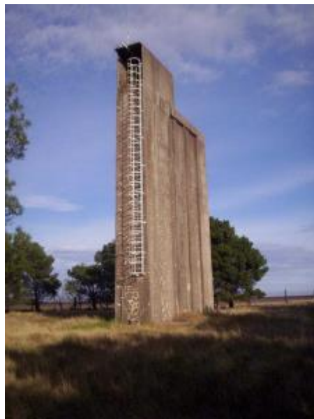
Figura 8: Acueducto Principal – Hormigón Pretensado
