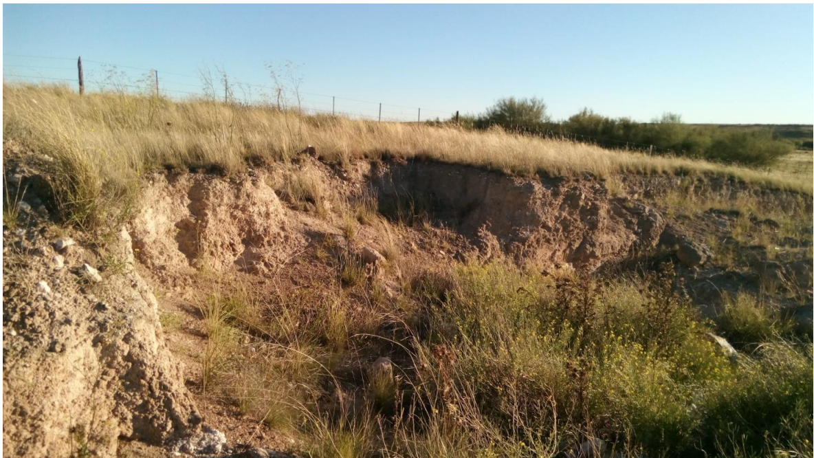
Figura 34: Corte en la Ruta N° 3 de antiguas terrazas
