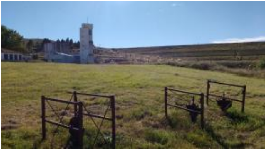
Figura 9: Cuadro de válvulas salida casa de bombas Dique
