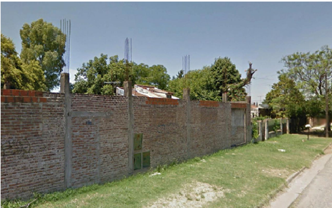
FIGURA 20 Vereda de pasto en Calle el Zorzal. Comienzo del Colector Johnston Cuenca 3
