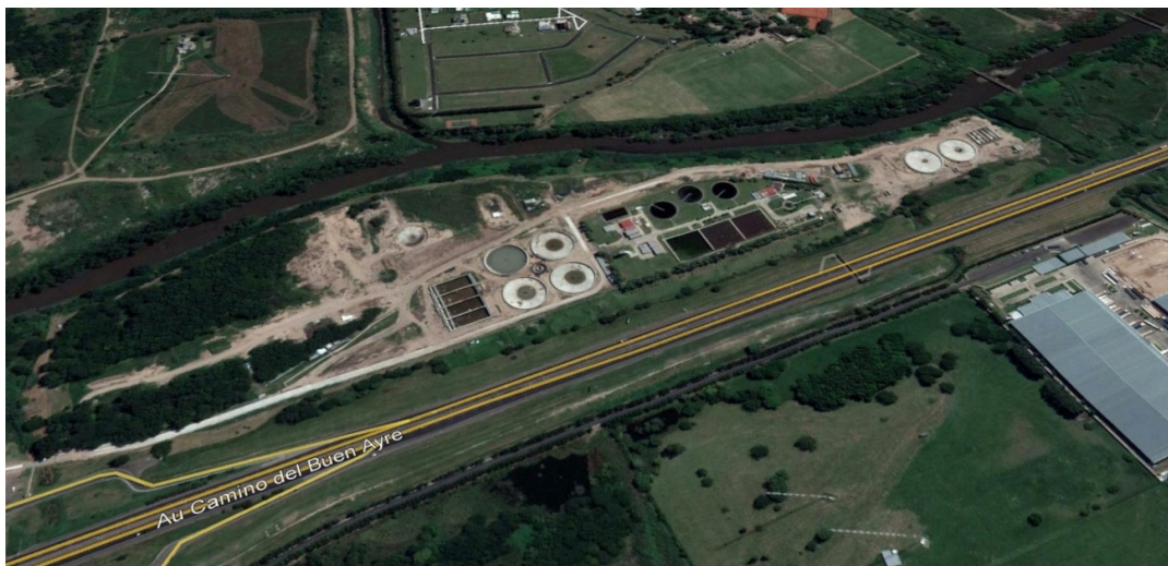
Figura 1: Planta Depuradora de Hurlingham.
