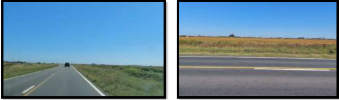
Figura 55 – Tramo del Acueducto French – Carlos Casares
