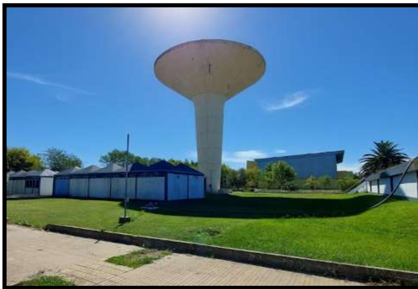
Figura 63 – Tanque elevado de almacenamiento en Coronel Vidal.
