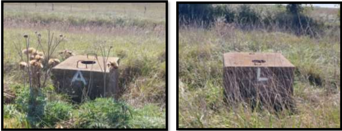
Figura 62 – Cámaras de limpieza y aireación del acueducto Gliptodonte – General Pirán
