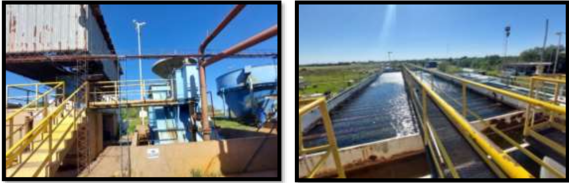
Figura 58 – Planta Potabilizadora de Agua de Carlos Casares
