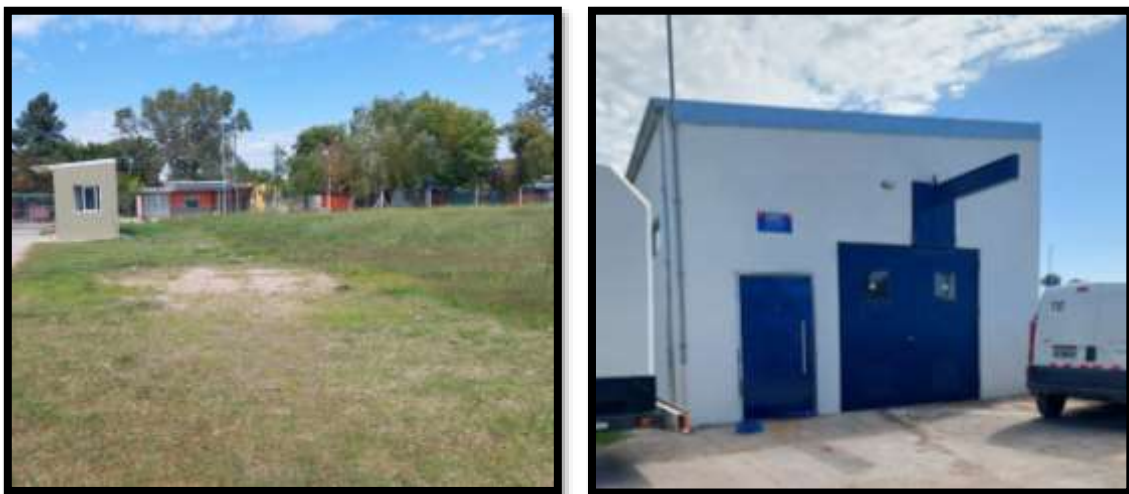
Figura 70 – Estación de Bombeo y cisterna, Establecimiento ABSA Marcos Paz
