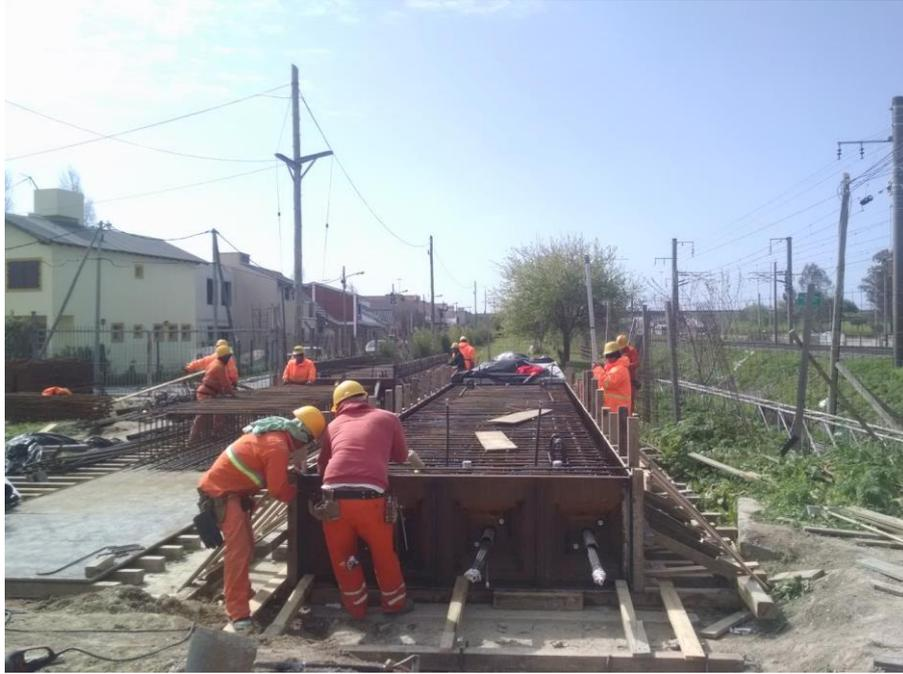
**Figura 13: Armado de Viga de puente ferroviario. Se colocan las vainas con cables de pretensado.**
