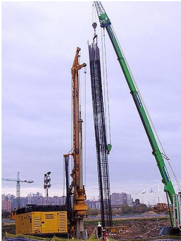
**Figura 11: Colocación de armaduras a través de grúas**
