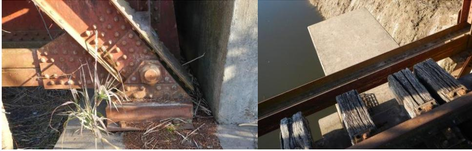
**Figura 2: Puente principal actual: a) *Vista general del puente* y b) *Vista superior en dirección longitudinal*, c) *Detalle Reticulado y Mecanismo de Apoyo*, d) *Detalle del tablero abierto, durmientes y rieles*.**
