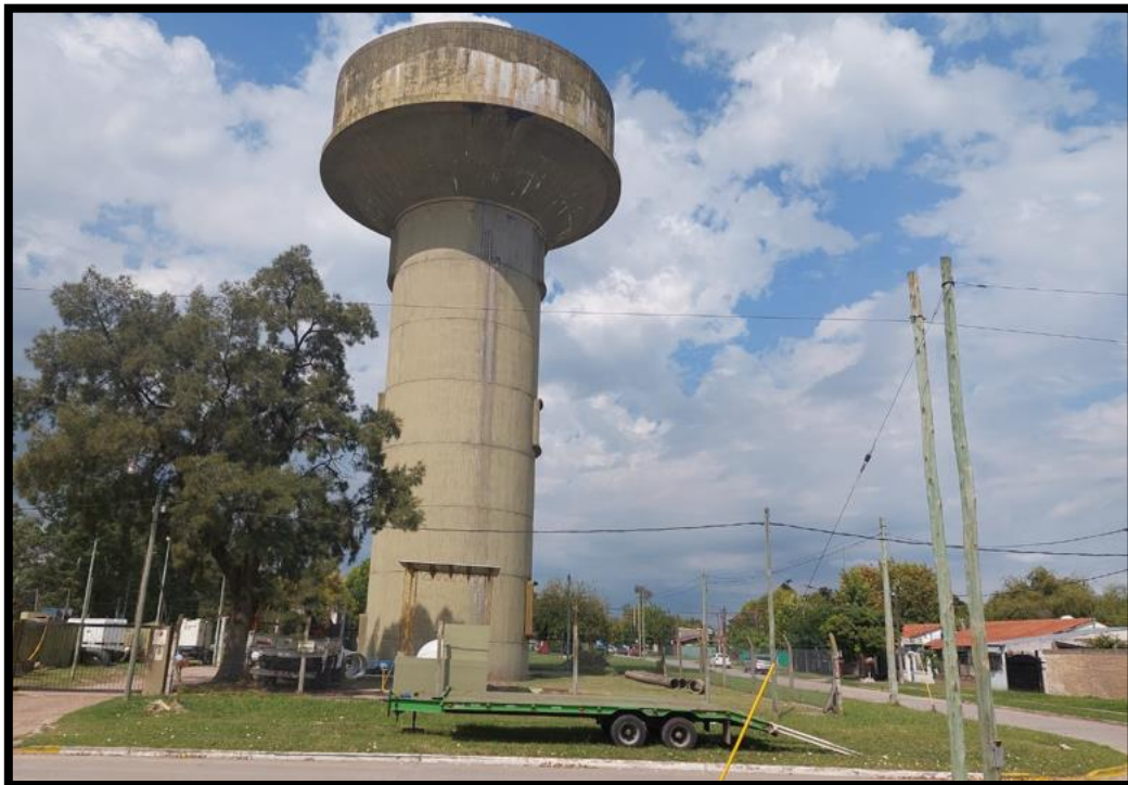
Figura 83 – Cisterna y estación de bombeo existente, Establecimiento ABSA San Vicente.
