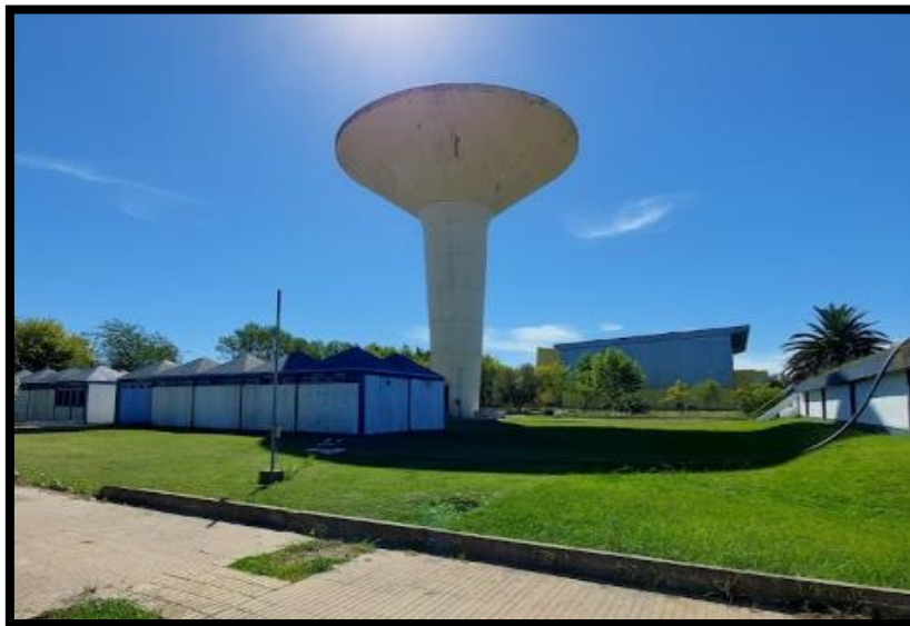
Figura 73 – Tanque elevado de almacenamiento en Coronel Vidal.
