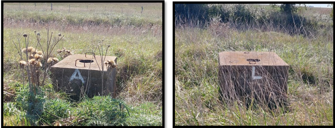
Figura 72 – Cámaras de limpieza y aireación del acueducto Gliptodonte – General Pirán
